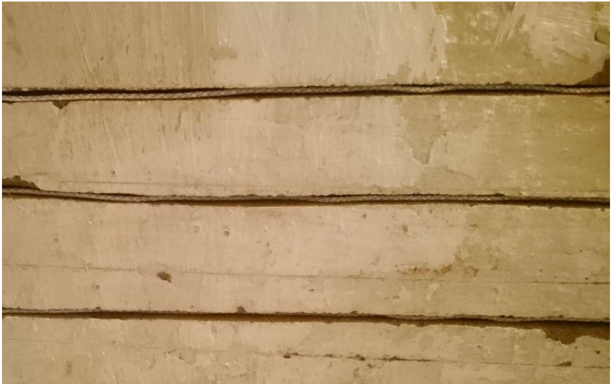
Verlegung der Wandheizung im Mauerschlitz
