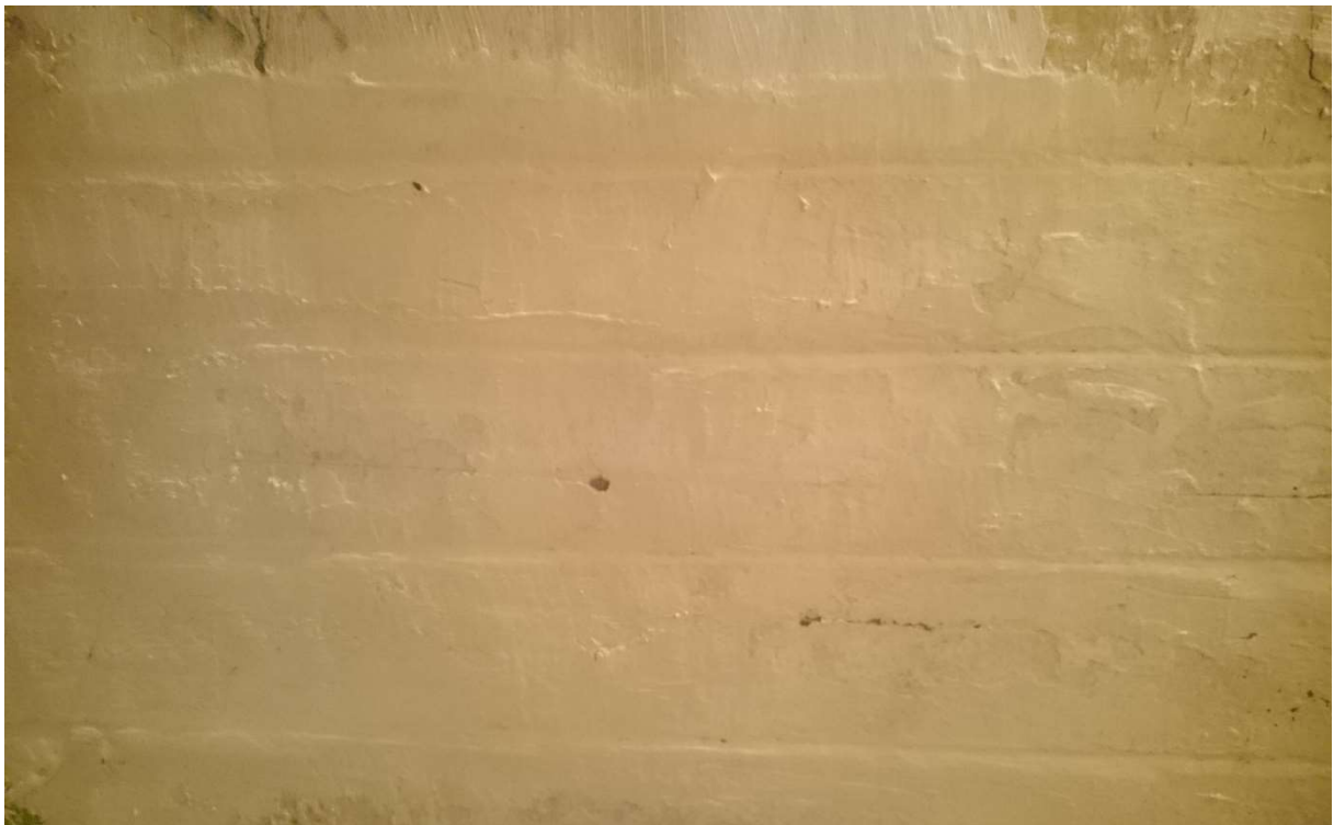
Verspachtelte Mauerschlitz mit innenliegender Wandheizung
